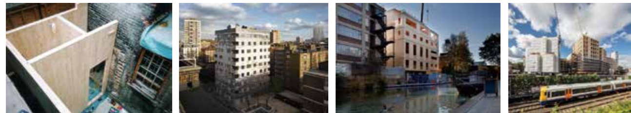
図1 2003年、英国初のCLT建築。南ロンドンのハットリ・ジョウジ邸、3階建て45m 2 の増築工事。大工3人によって運搬車両から直接パネルを吊り上げ、わずか半日で精確に施工された。 図2 2009年、9階建集合住宅のStadthaus竣工。毎年9月、建物の前ではオープンハウスイベントに合わせて木質建築の公開トークを行う。住民自らが彼らの住まいのよさ：防音性、快適な室内温熱環境、住み心地そのものについて語る。プロジェクトを重ねるに従い、木材が石やコンクリートとは異なる熱力学的傾向を有することが明らかになった。 図3 精密なプレカット技術は20世紀までの従来方法を超える高い精度で現場での組み立て施工を実現した (Whitmore Road)。 図4 最新プロジェクトDalston Lane。延床面積17,000m 2 の10階建集合住宅。設計事務所の3D図面データはエンジニア、CLTプレカット工場と共有された。デジタルな直結により、建築家は単なるグラフィックデザイナーではなく、再び施工プロセスへ深く関与する。ミスなら何と言ったのだろうか？
